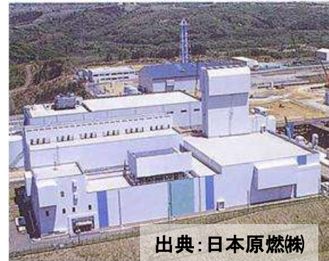
高レベル放射性廃棄物 貯蔵管理センター (青森県六ヶ所村)
